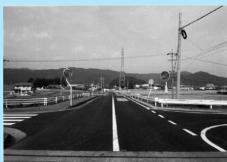
▲町道28号線舗装修繕工事完成時の写真
