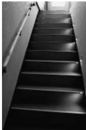
階段足元灯と光る手すり
