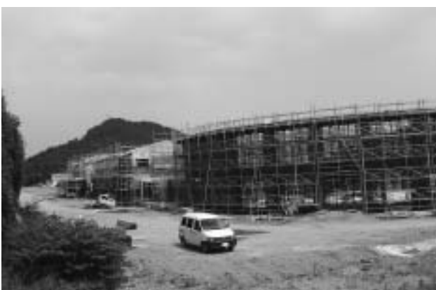
建設中の谷汲総合小学校
