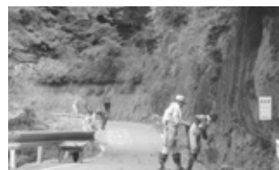
県道春日揖斐川線 (春日川合地区)
