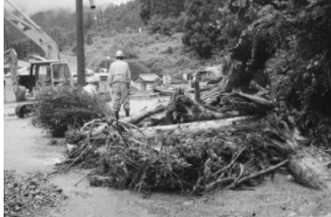
久瀨トンネル付近・町道から
