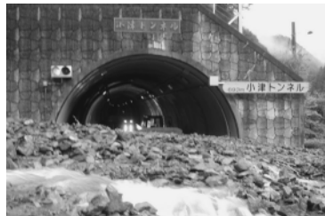
小津トンネル入り口
