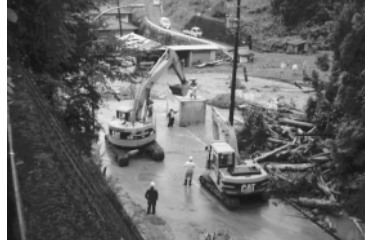
久瀨トンネル付近・入口上部より
