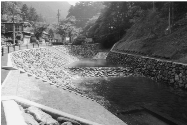
▲河川環境に配慮された工法の坂本谷
