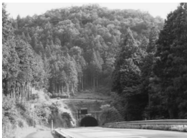
大谷トンネル付近
