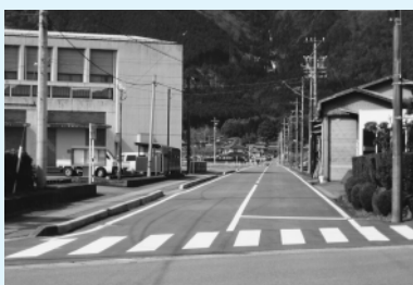
▲町道7号線舗装修繕工事完成時の写真
