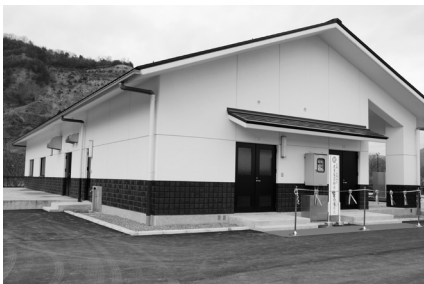
▲徳積・長瀬地区排水処理施設
