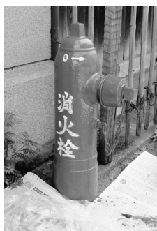
▲塗装補修完了!!
