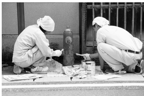
▲塗装補修作業の様子
