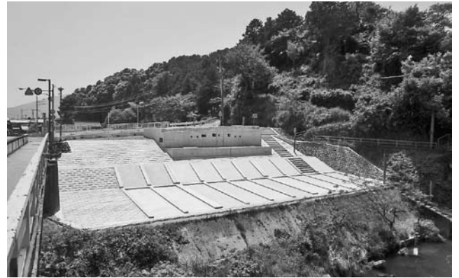
▲揖斐川右岸の橋台
