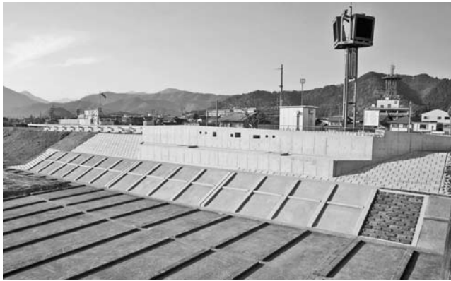
▲揖斐川左岸の橋台
