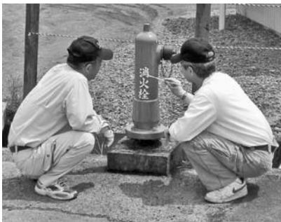
▲塗装補修作業の様子
