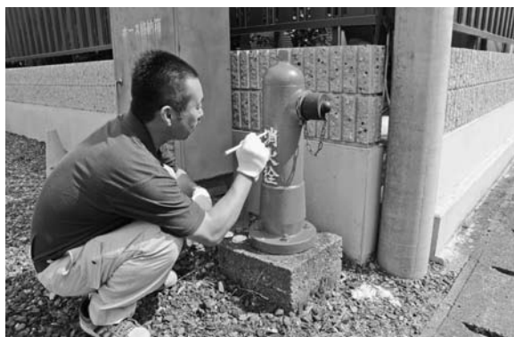
▲塗装補修作業の様子
