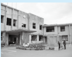
被災した大槌町役場
