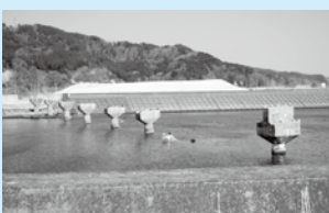
橋げただけが残された鉄道の橋梁
