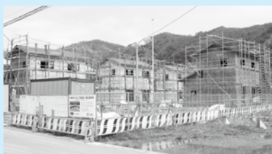
建設が進む災害公営住宅
