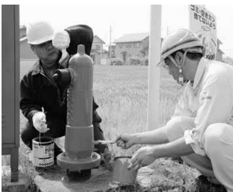
▲真っ赤に蘇った消火栓(胥永)
