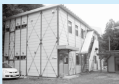
ボランティアセンター （社会福祉協議会）の建物
