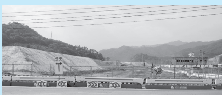
進む盛土作業
