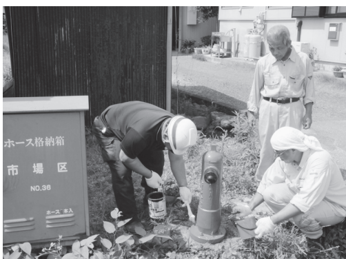
▲消火栓の塗装をする水道組合の皆さん
