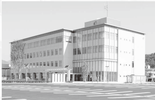
▲庁舎 兼 防災センター（平成 23 年 7 月）
