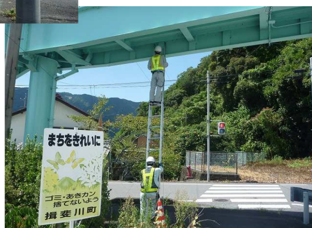
近接目視による点検状況
