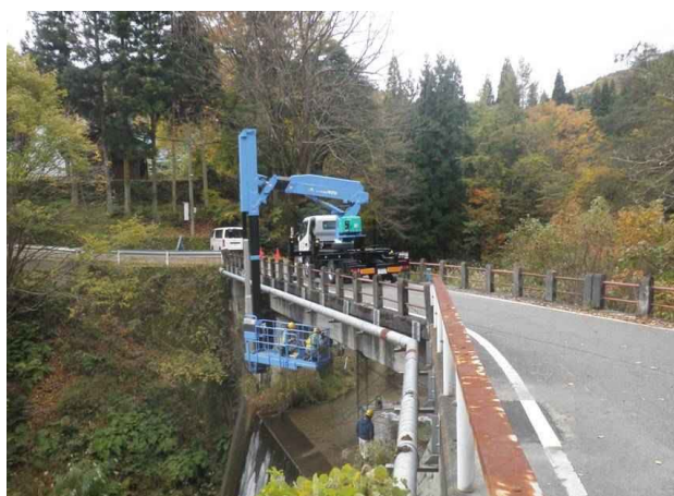
近接目視による点検状況 (橋梁点検車を使用)
