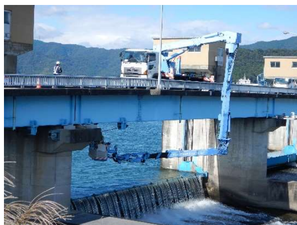
近接目視による点検状況 (橋梁点検車を使用)
