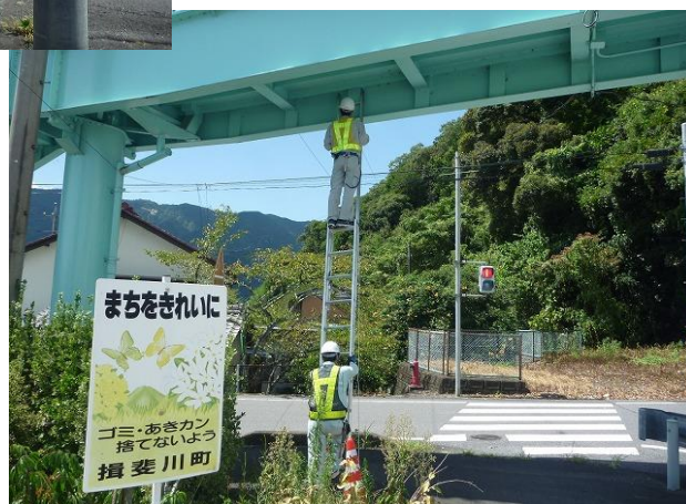
近接目視による点検状況
