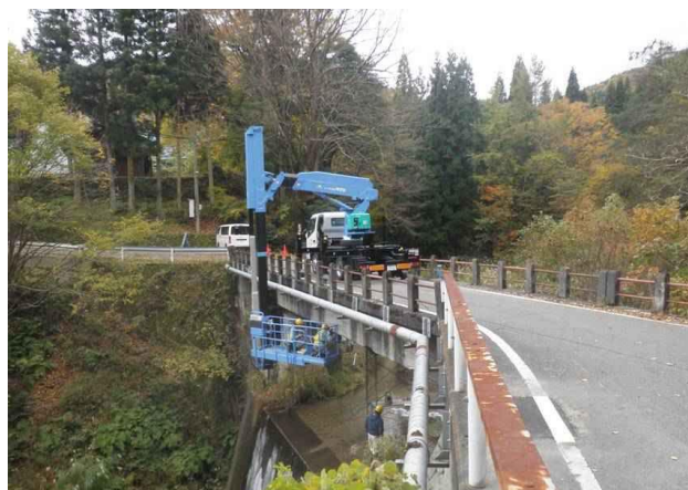
近接目視による点検状況（橋梁点検車）
