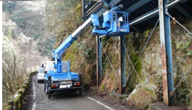
近接目視による点検状況
