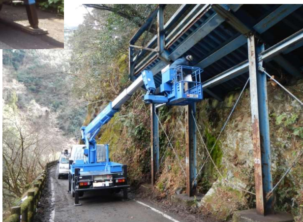
近接目視による点検状況
