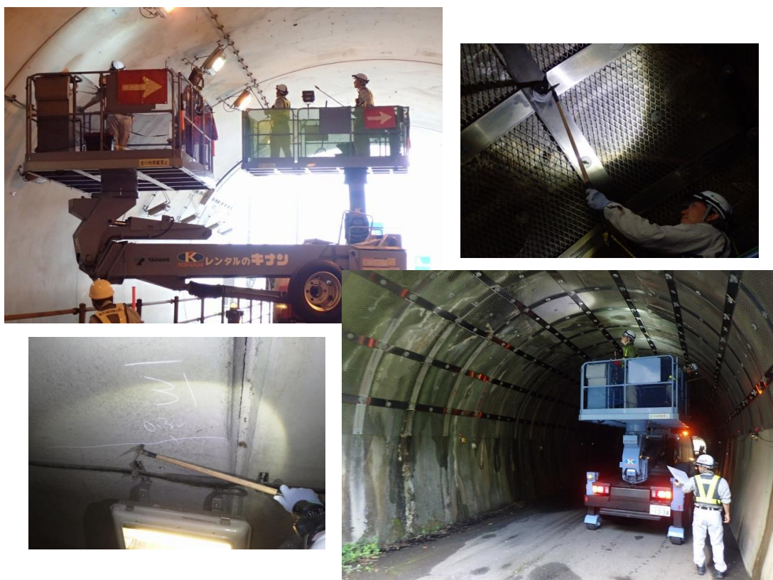
近接目視による点検状況
