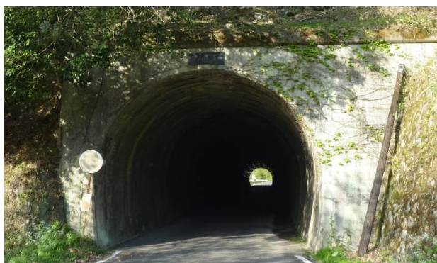
神山トンネル
