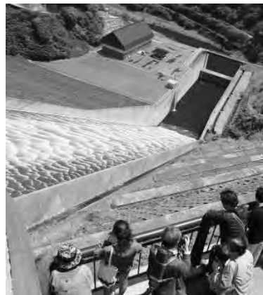
▲洪水吐きゲートから放流
