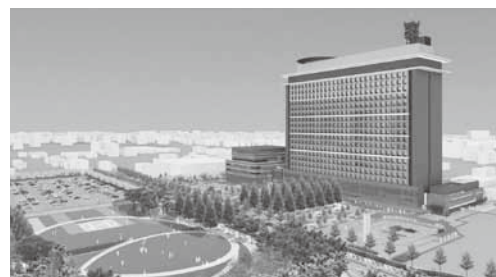
新県庁舎外観
