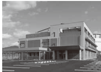
県障がい者総合就労支援センター外観
