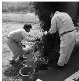
▲塗装作業の様子
