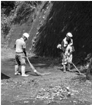
▲清掃作業の様子
