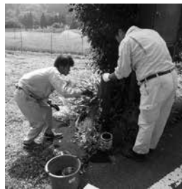
▲塗装作業の様子
