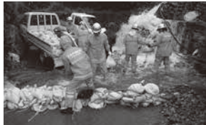
道路や民家への流入を防ぐ土のう積み
