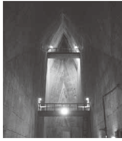
▲横山ダムの中空部
