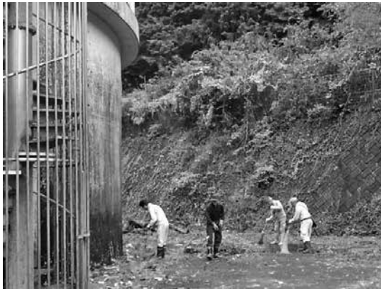
▶配水池周辺の清掃の様子
