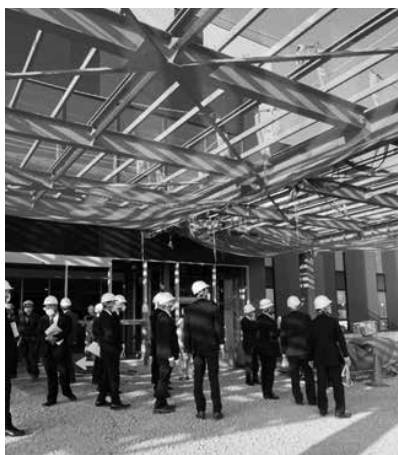
▶西濃厚生病院建設工事現場視察の様子
