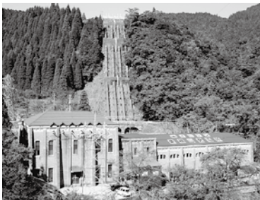
▲東横山発電所
