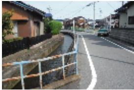
転落防止柵設置済み
