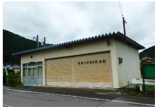
35_消防団本部久瀬車庫_久瀬本部
