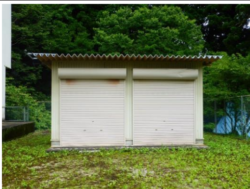
20-3_日坂公民館_久瀬日坂公民館器具庫_倉庫
