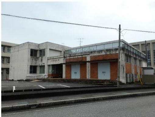
14_揖斐川町小島公民館
