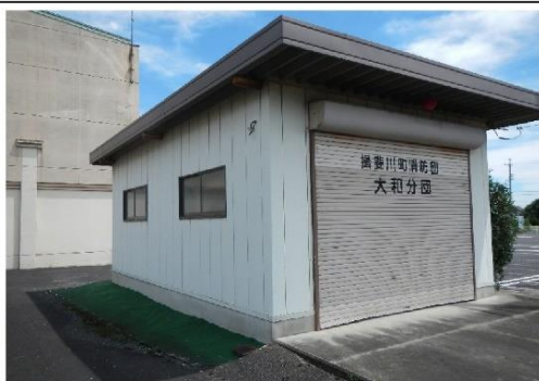
08_消防団大和分団車庫(房島)
