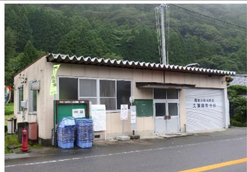
37_消防団久瀬南部分団車庫(乙原)
