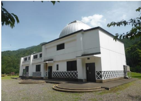
08-1_藤橋城・西美濃天文台・藤橋歴史民俗資料館_西美濃天文台
