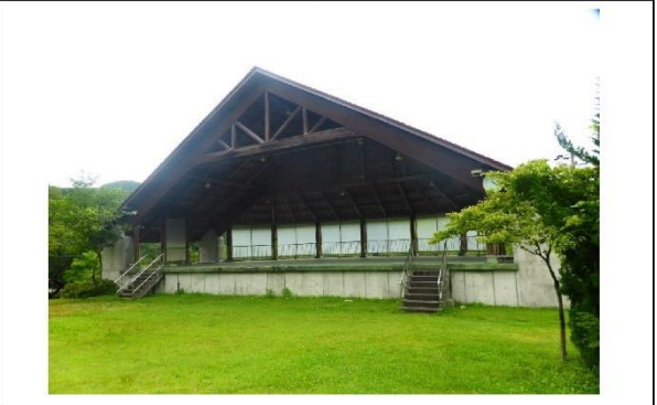
19-6_貝月森林総合利用施設(貝月リゾート)_音楽堂・ホール
