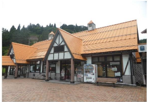
27-2_道の駅星のふる里藤橋_地域特産物販売施設
