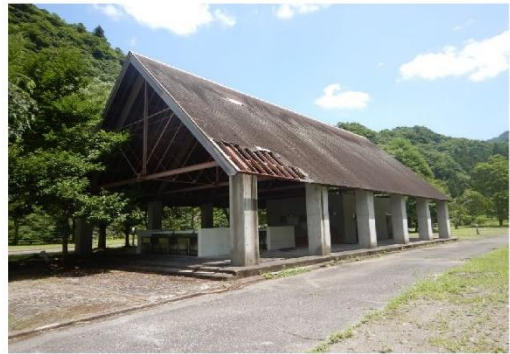
23-2_藤橋オートキャンプ場_サニタリー棟
