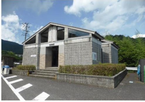
34-2_谷汲第1駐車場(南側)_公衆トイレ
