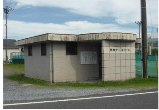
10_揖斐川テニスコート管理棟
