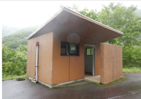
38_夜叉ヶ池駐車場公衆トイレ
