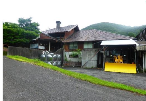
19-2_貝月森林総合利用施設(貝月リゾート)_管理棟
