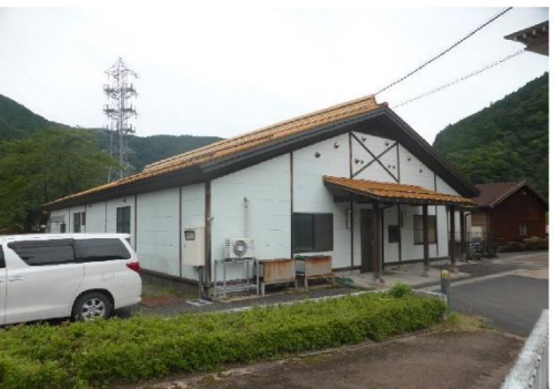
27-5_道の駅星のふる里藤橋_藤橋農林水産物処理加工施設
