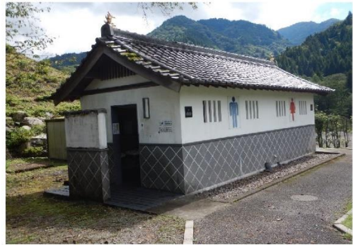
22_藤橋城公園トイレ
