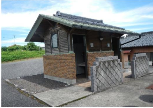
09_北和グラウンド_公衆トイレ
