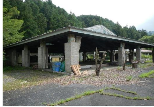
10_谷汲老人生きがいドーム_ゲートボール場
