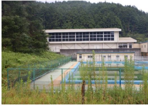
08-2_揖斐特別支援学校_屋内運動場
