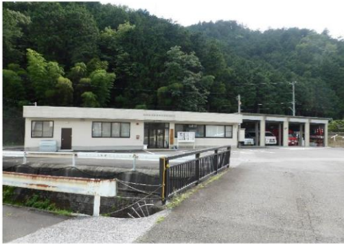
10_谷汲消防団活性化センター
