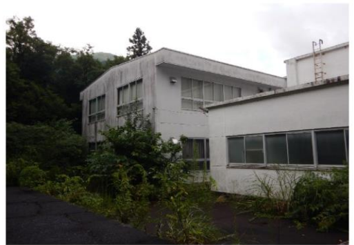
05-4_久瀬中学校_多目的教室
