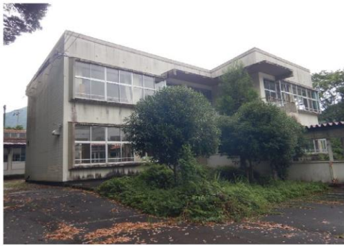
05-1_久瀬中学校_校舎(特別教室)
