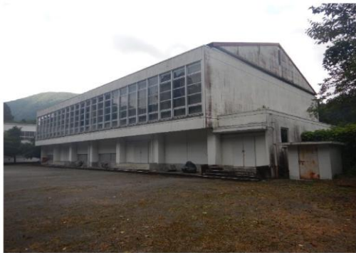
05-3_久瀬中学校_屋内運動場
