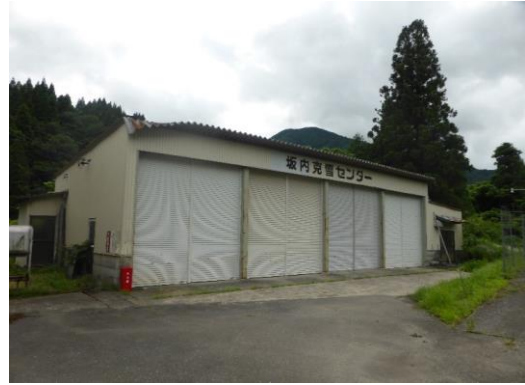
12_克雪センター
