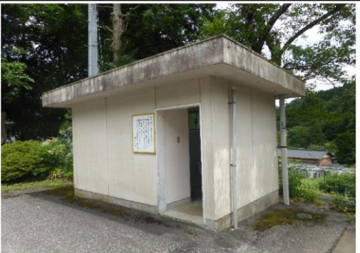
51_広瀬中央公民館公衆トイレ
