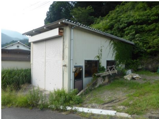
11_上ヶ流除雪ドーザ車庫
