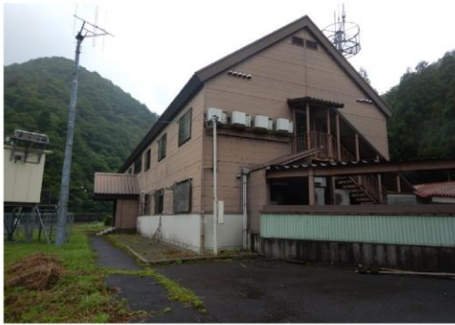
19-2_スローライフ夜叉ヶ池の里_夜叉姫の館(宿泊棟)
