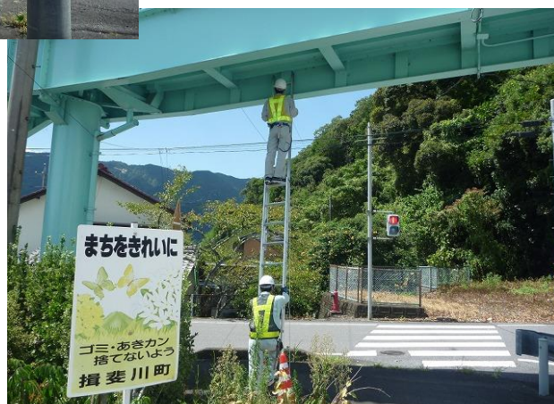
近接目視による点検状況
