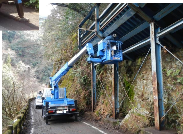
近接目視による点検状況
